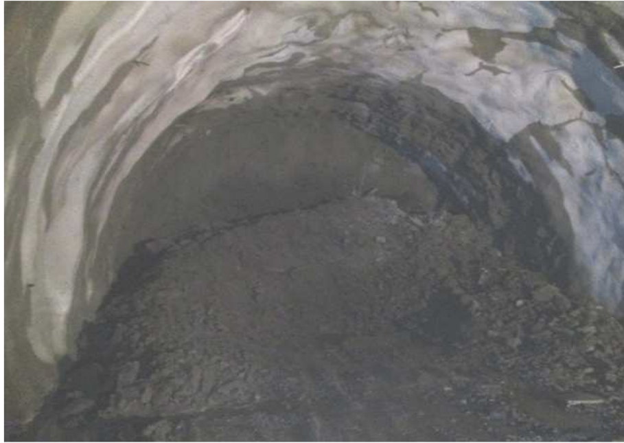
STA 0+320 터널 굴착 현황
