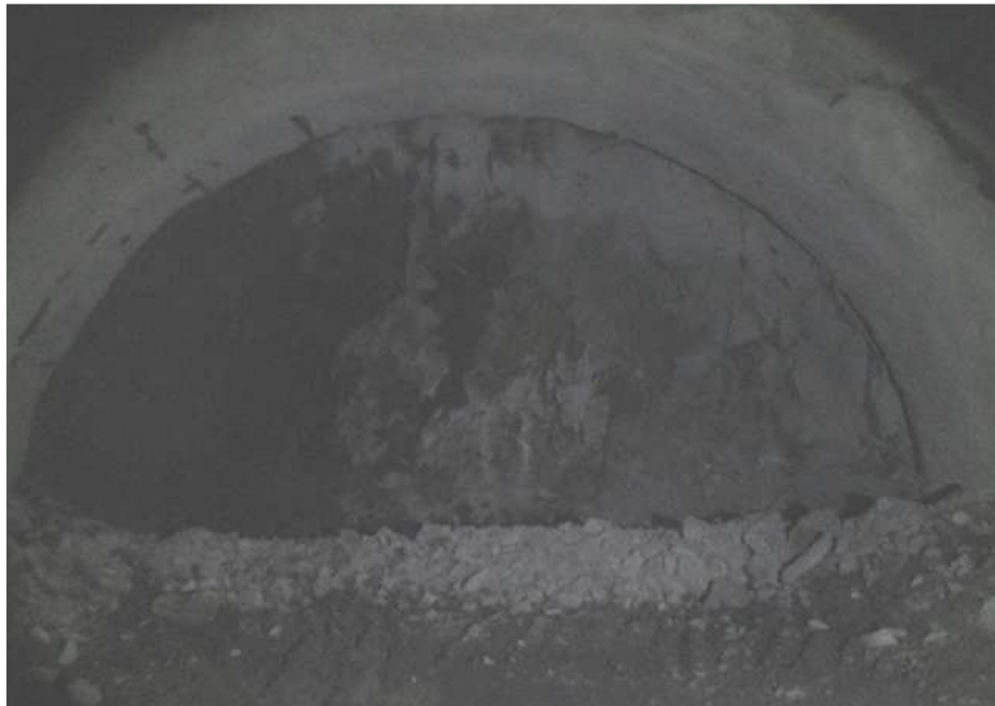
STA 0+090 터널 굴착 현황
