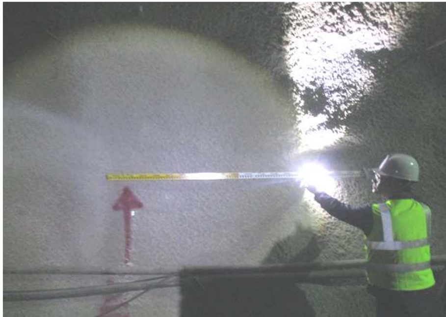
STA 0+180 강지보재 현황
