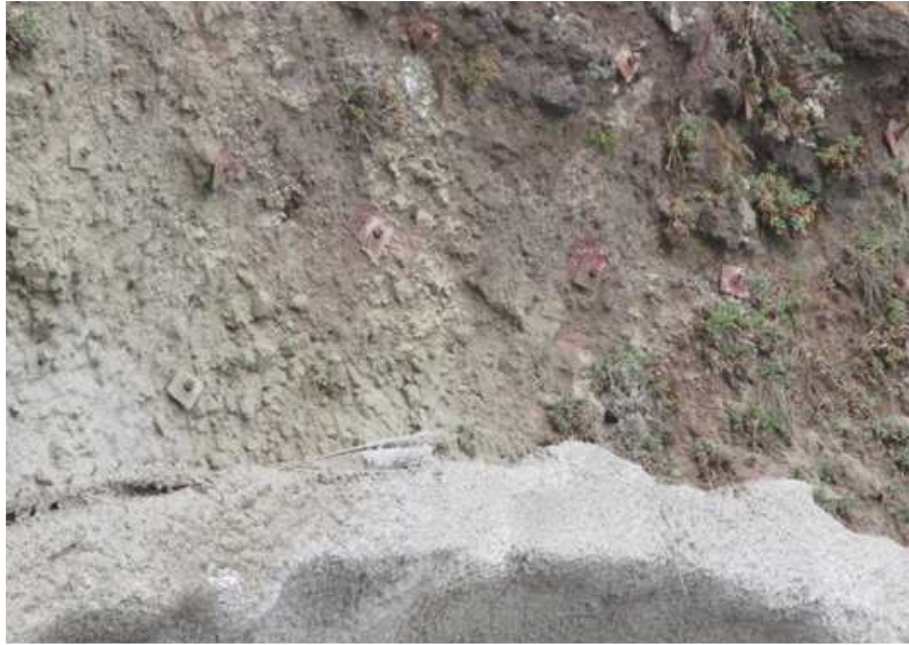
시점측 록볼트 사면 보강 현황
