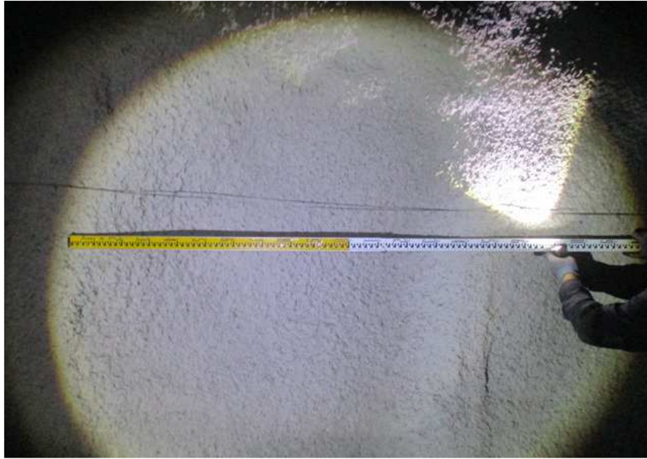
STA 0+220 강지보재 현황
