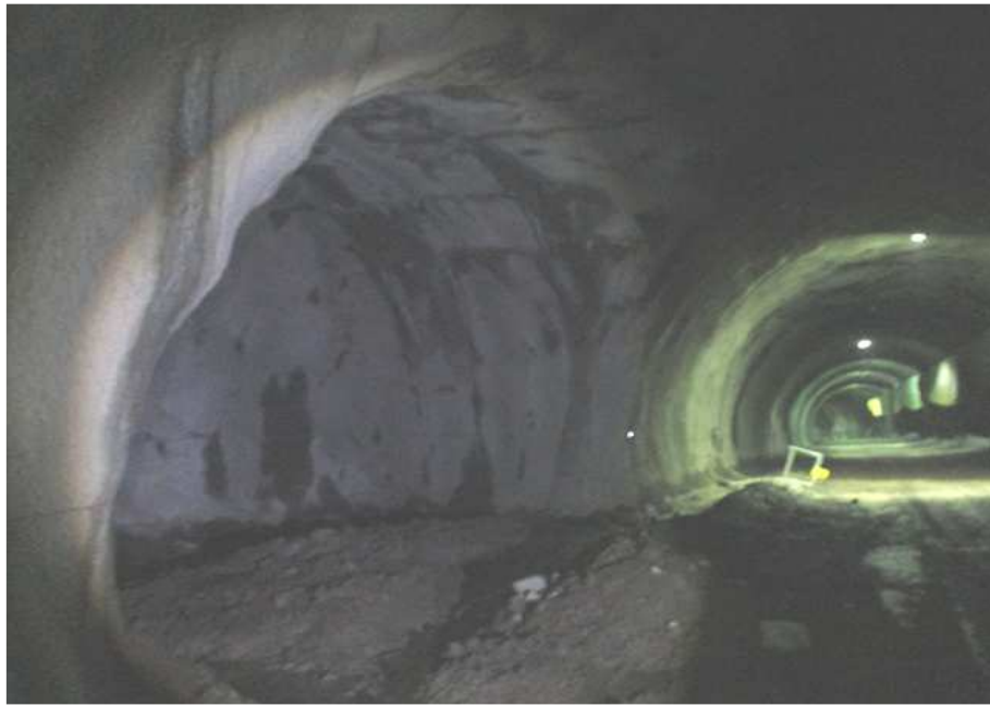
STA 0+289(방향전환소) 현황
