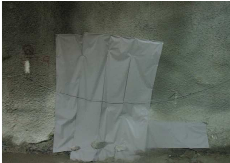
STA 0+466 방수막 설치 현황
