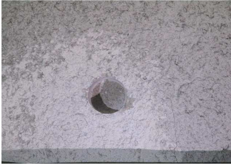
STA 0+160 솟크리트 현황
