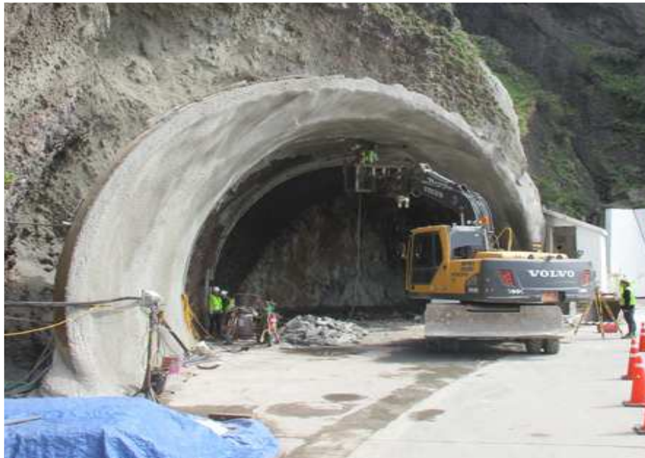
시점측 갱구부 시공 현황
