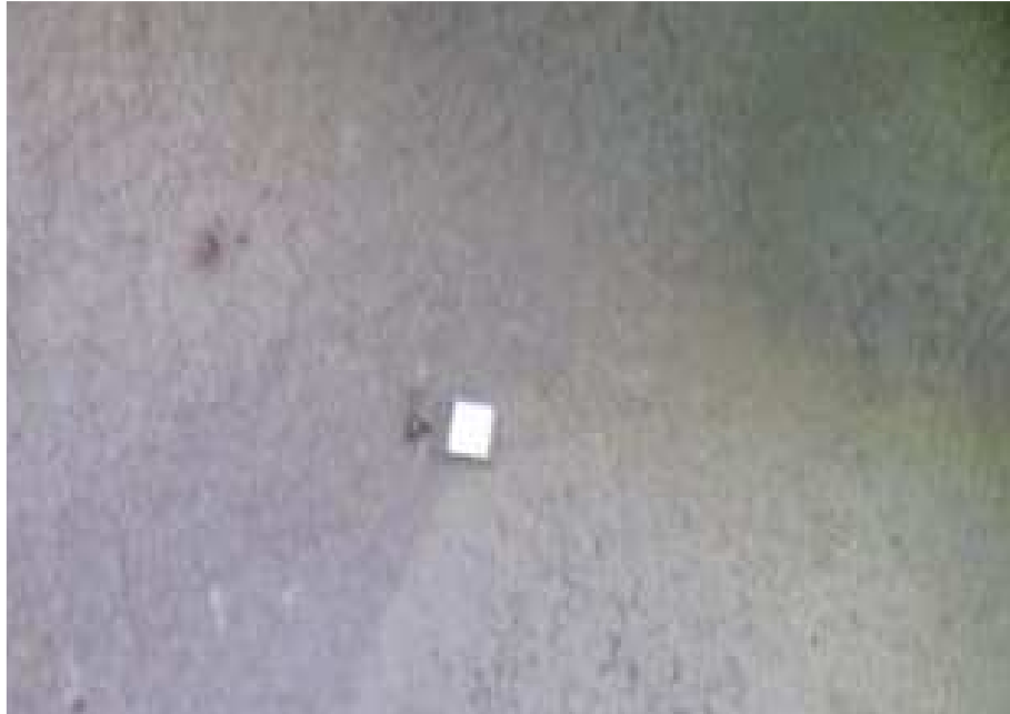
STA 0+510 내공 계측 현황
