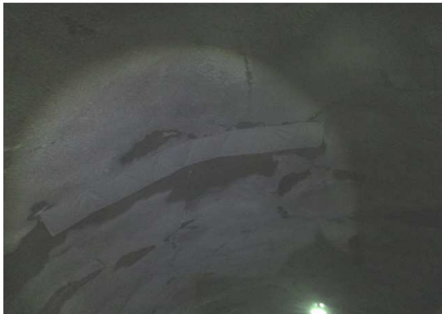
STA 0+240 방수막 설치 현황
