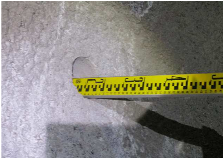
STA 0+160 솟크리트 현황
