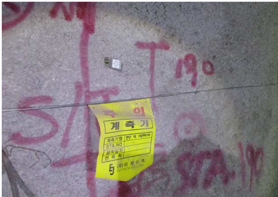
STA 0+190 내공 계측 현황
