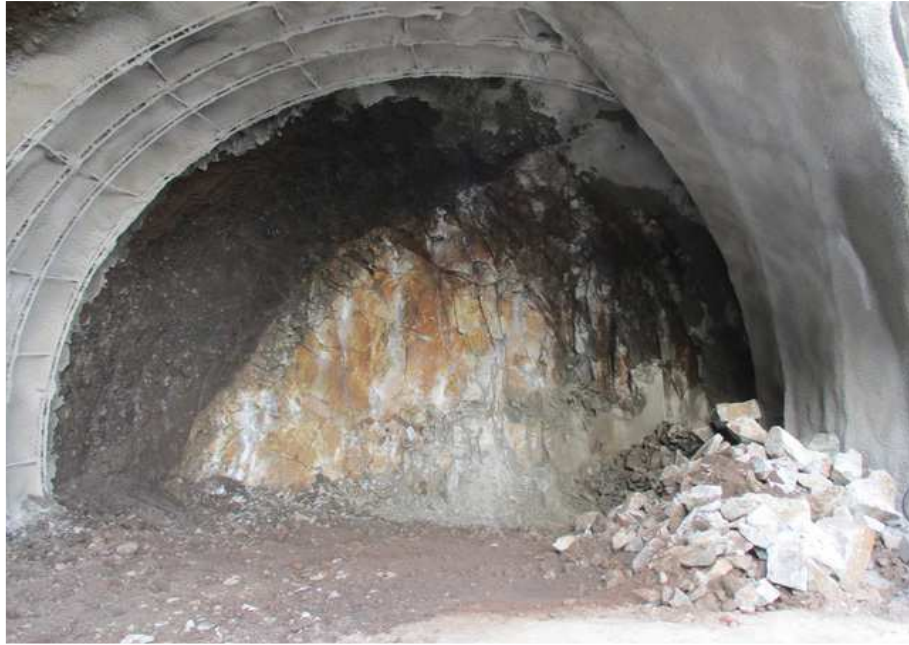
STA 0+070 터널 굴착 현황
