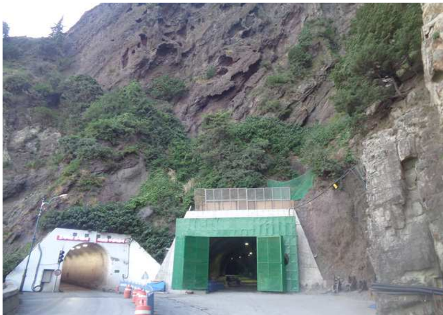
서면1터널 종점부 내부 전경
