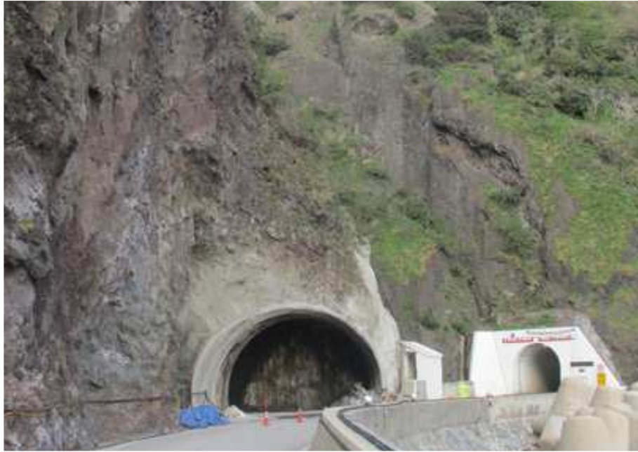
서면1터널 시점부 갱구 전경
